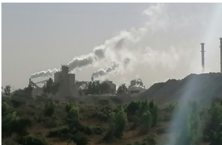
Photo 10: Emanations de fumées des installations des ICS
