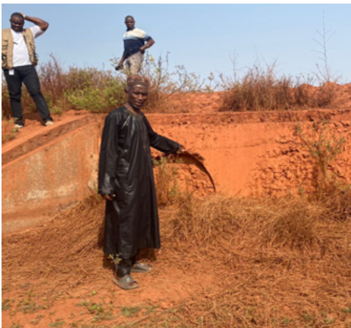
Planche 21-Fermeture d'un canal d'évacuation traversant la route minière
