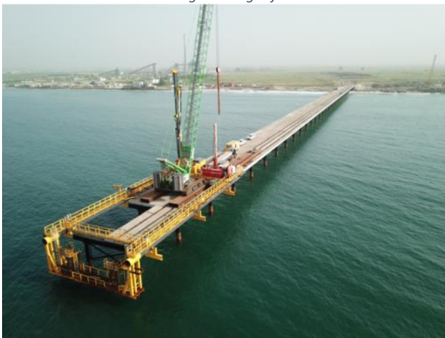
Photo 4 : Installation de chevêtres et dalles constituant la jetée en mer
