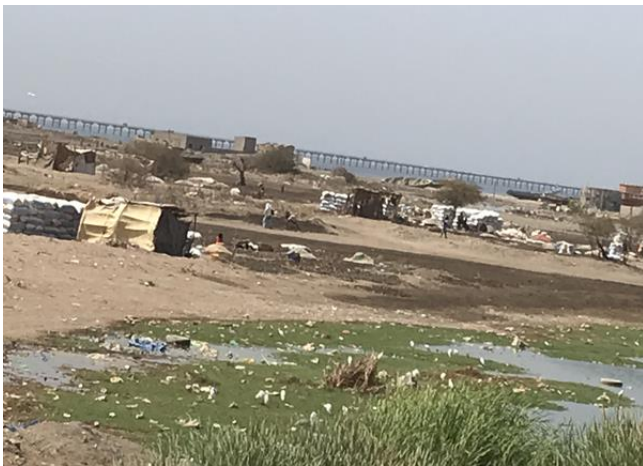
Photo 2 : Jetée en mer du Port vue côté site de Khelcom et du marigot de Ngadjé
