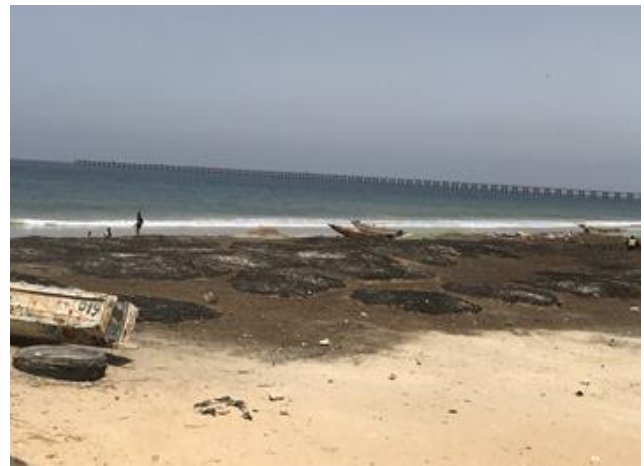
Photo 3 : Jetée en mer du Port vue côté Sendou (site de fumage du poisson)
