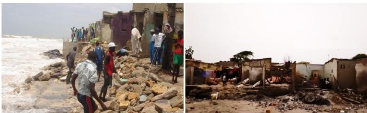
Photo 16 : Erosion côtière au niveau du quartier de Bargny Guédj
