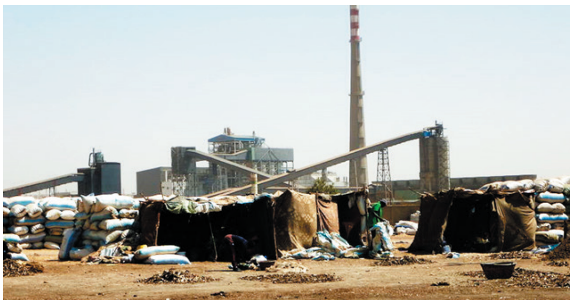
Photo 20 - abris de femmes de khelcom en contiguïté avec la centrale à charbon.png
