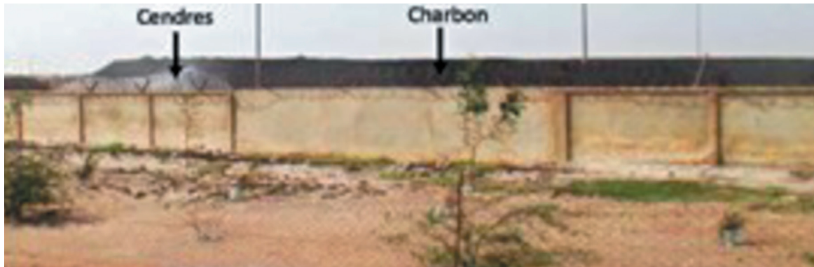
Photo 8 - dépôt de charbons et de cendres dans l'enceinte de la centrale
